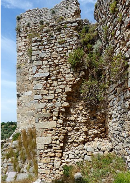
Teil der Burgmauer von Beçin Kalesi.
