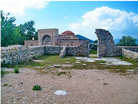
Blick über die ruinierten Mauern der Orhan-Moschee auf die Ahmed-Gazi-Medrese, im Mittelgrund rechts Stücke des Marmor-Fußbodens der Moschee. Erkennbar sind auch am Boden die runden Platten, auf denen Holzsäulen standen
