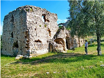
Der ruinierte Kızıl Han. Gut erkennbar ist die Außentreppe ins Obergeschoss
